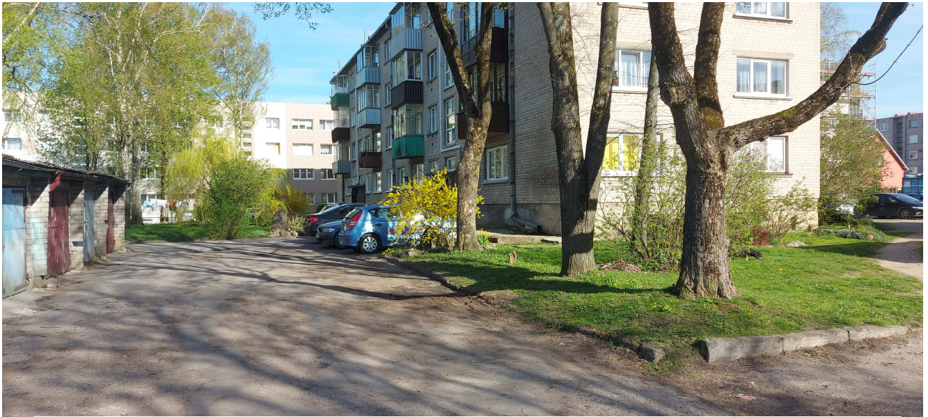
8 pav. Planuojamos teritorijos vidaus erdvė ties daugiabučiu gyvenamuoju pastatu Vytauto g. 28A
