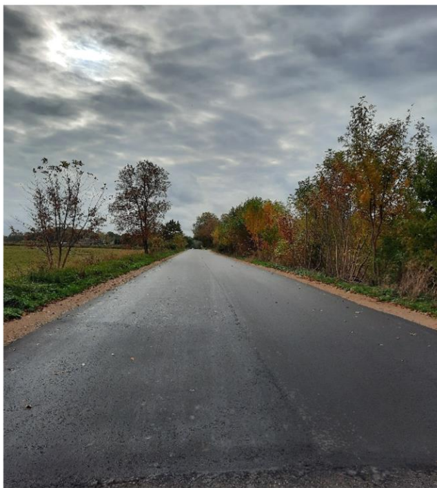
Atnaujinta asfalto danga dalyje kelio Kurmaičiai- Tūbausiai.
