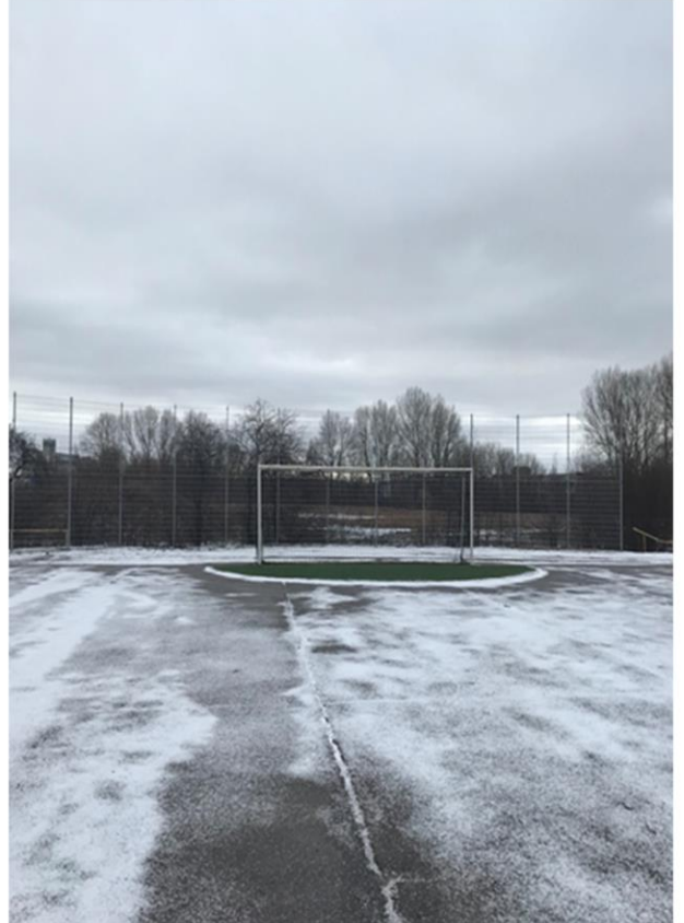
Motobolo aikštės apsauginių atitvarų (kamuolių gaudyklių) įrengimo darbai
