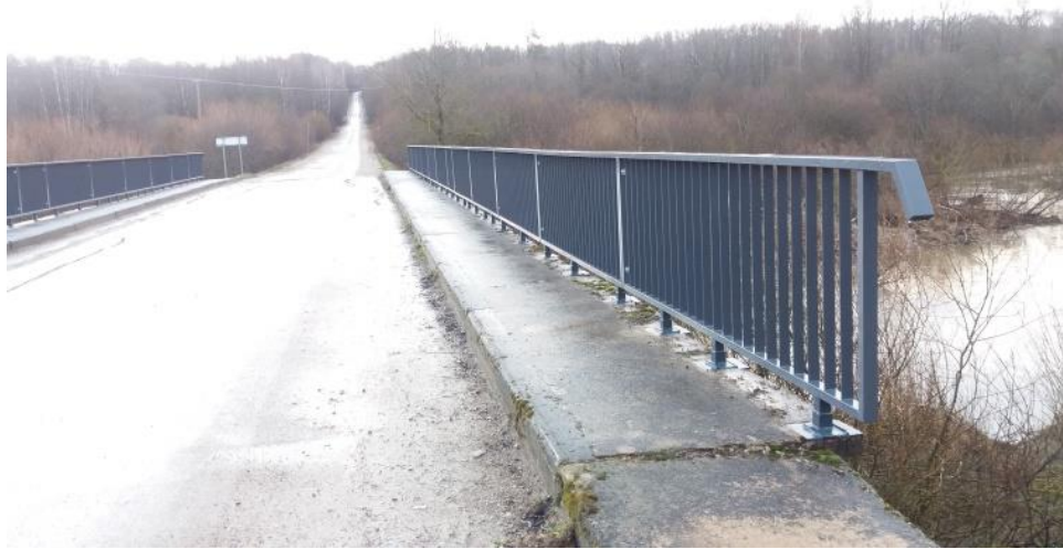
55 pav. 34 m. ilgio tilto per Salanto upę, kelyje Kūlupėnai–Prystovai, atitvarų turėklai pakeisti naujais
