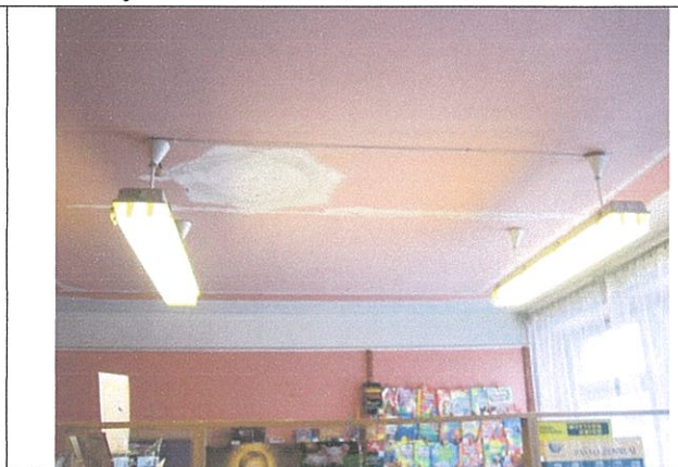
Dėl drėgmės pažeista pastato vidaus apdaila
