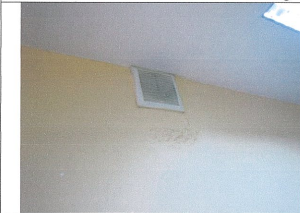
Dėl drėgmės pažeista pastato vidaus apdaila
