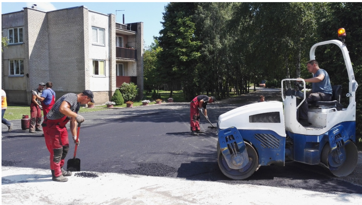
94 pav. Ištinė asfalto danga paklota Laukžemės k. Saulėtekio g.
