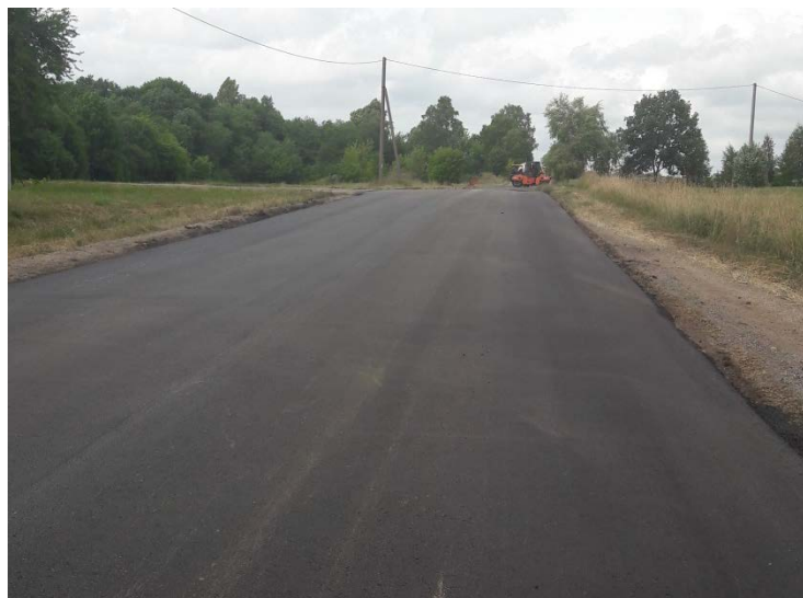
85 pav. Perklotas asfaltas kelyje į Tūbausius
