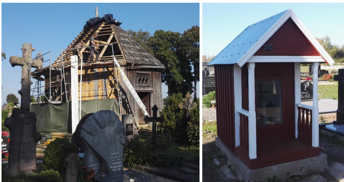
101 pav. Grūšlaukės kapinių koplyčia (prieš ir po remonto)
