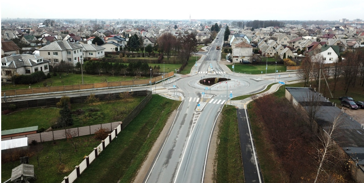
24 pav. Suremontuota J. Jablonskio g., kuri sujungta su 2017 m. užbaigta Melioratorių-J.Jablonskio g. žiedine sankryža
