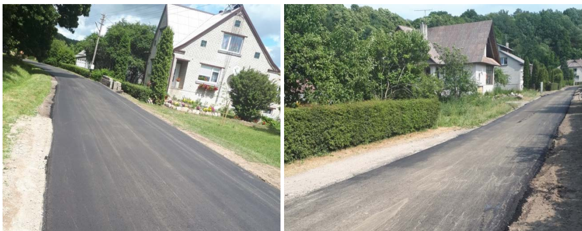
127 pav. Ištisinė asfalto danga paklota Pakalnės gatvei
