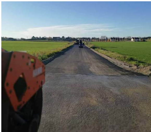
89 pav. Ištininės asfalto dangos įrengimas Pryšmančių k. Centro gatvėje
