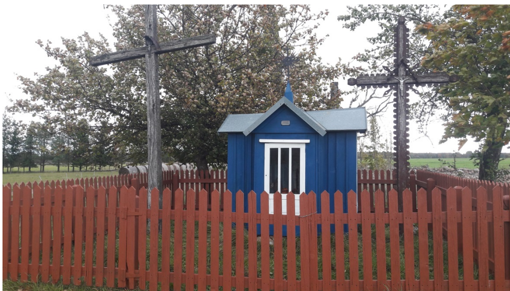
84 pav. Renovuota Genčių kaimo koplytėlė
