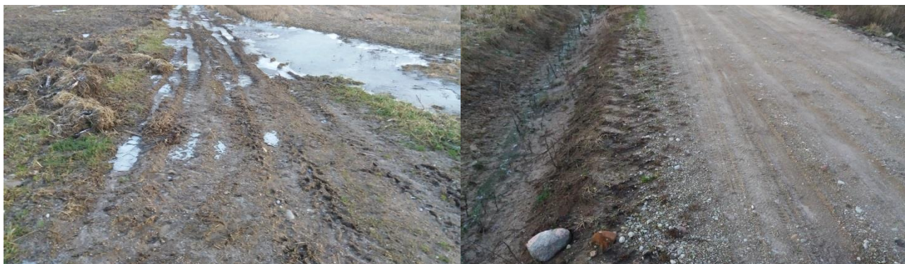
48 pav. Kelias Prystovų k. (iki ir po remonto)
