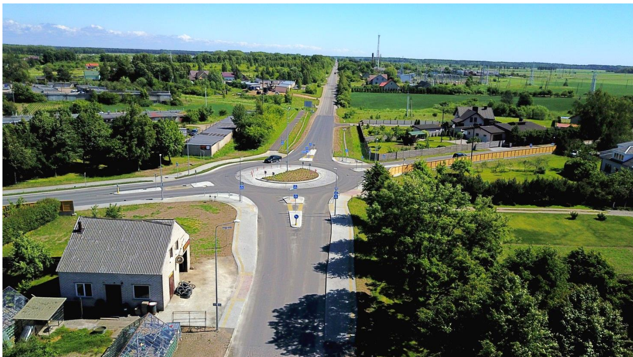
15 pav. Melioratorių – J. Jablonskio gatvių sankryžos rekonstravimas į žiedinę sankryžą (2017-06-14)
