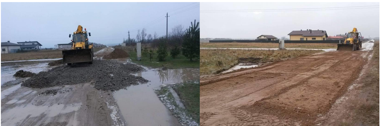
39 pav. Vydmantų seniūnijos kelių stiprinimas skalda
