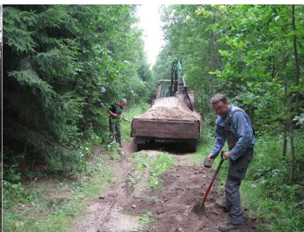
45 pav. Kelio remonto darbai į žydų žudynių vietą Žvainiuose
