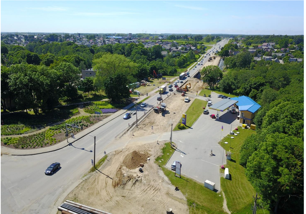
16 pav. Žemaitės alėjos per Kretingos miestą (valstybinės reikšmės magistralinis kelias Nr. A11 Šiauliai–Palanga) rekonstrukcija (2017-06-15)
