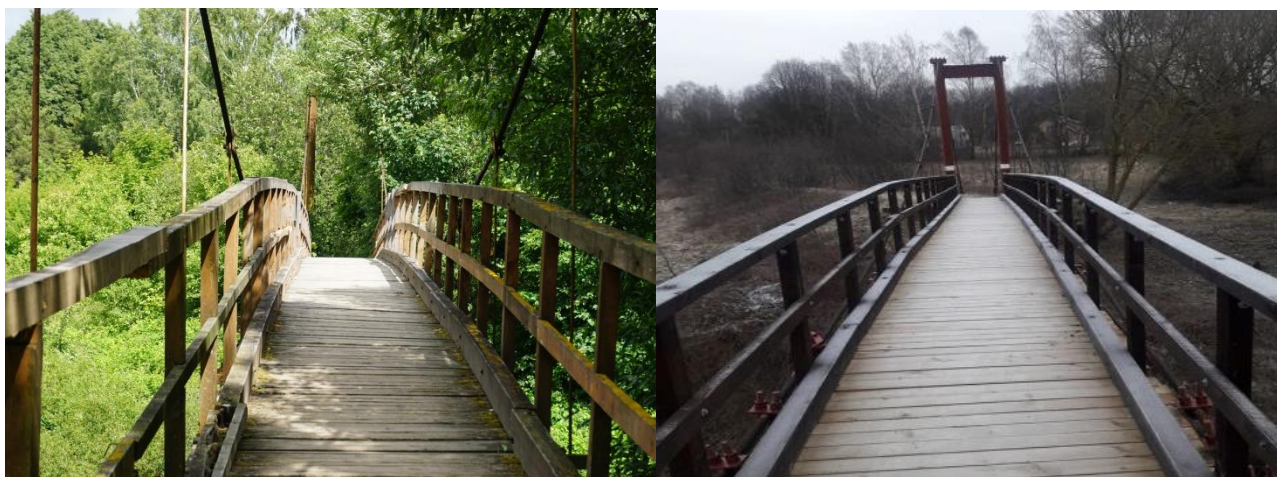
33 pav. Suremontuotas pakabinamas tiltas per Akmenos upę (prieš ir po)
