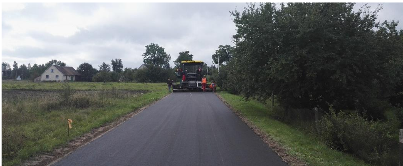
41 pav. Ištisinė asfalto danga paklota Nausėdų k. Ilgojoje g.
