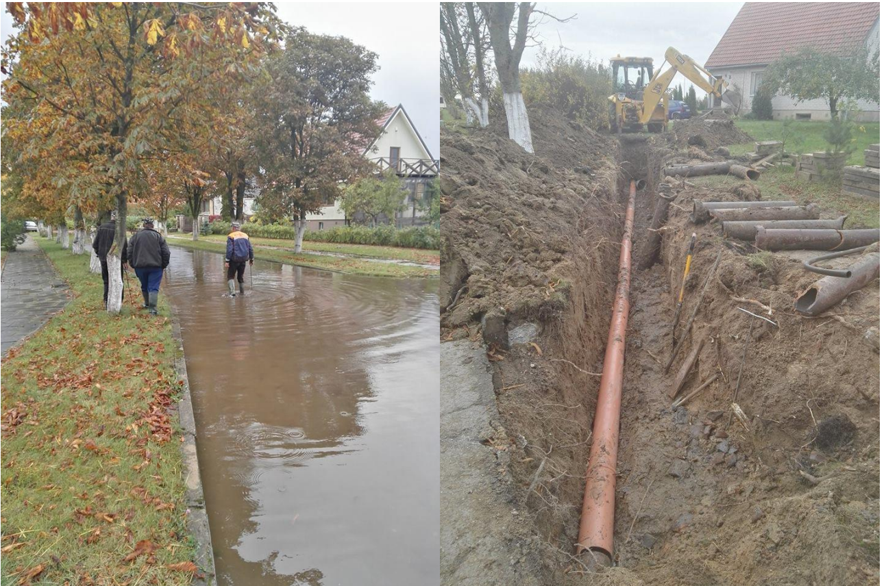
36 pav. Šalavijų akligatvyje, Vydmantų kaime, atnaujinta lietaus nuotekų trasa
