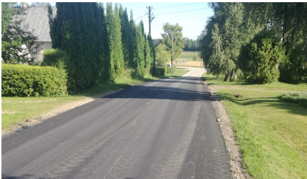
50 pav. Išasfaltuota Beržų gatvė Lubiuose
