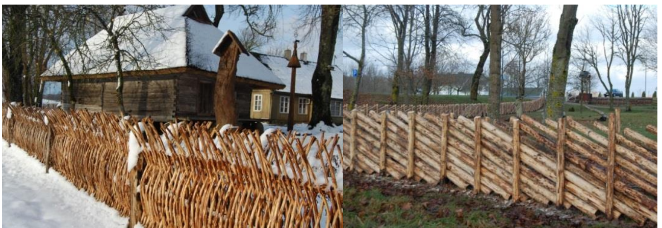
32 pav. Dalis Vyskupo Motiejaus Valančiaus sodybos muziejaus teritorijos aptverta žiogrių bei pusgulstine tvoromis
