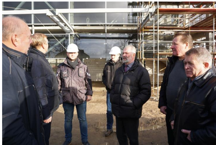
Svarbiausių objektų statybų apžiūra
