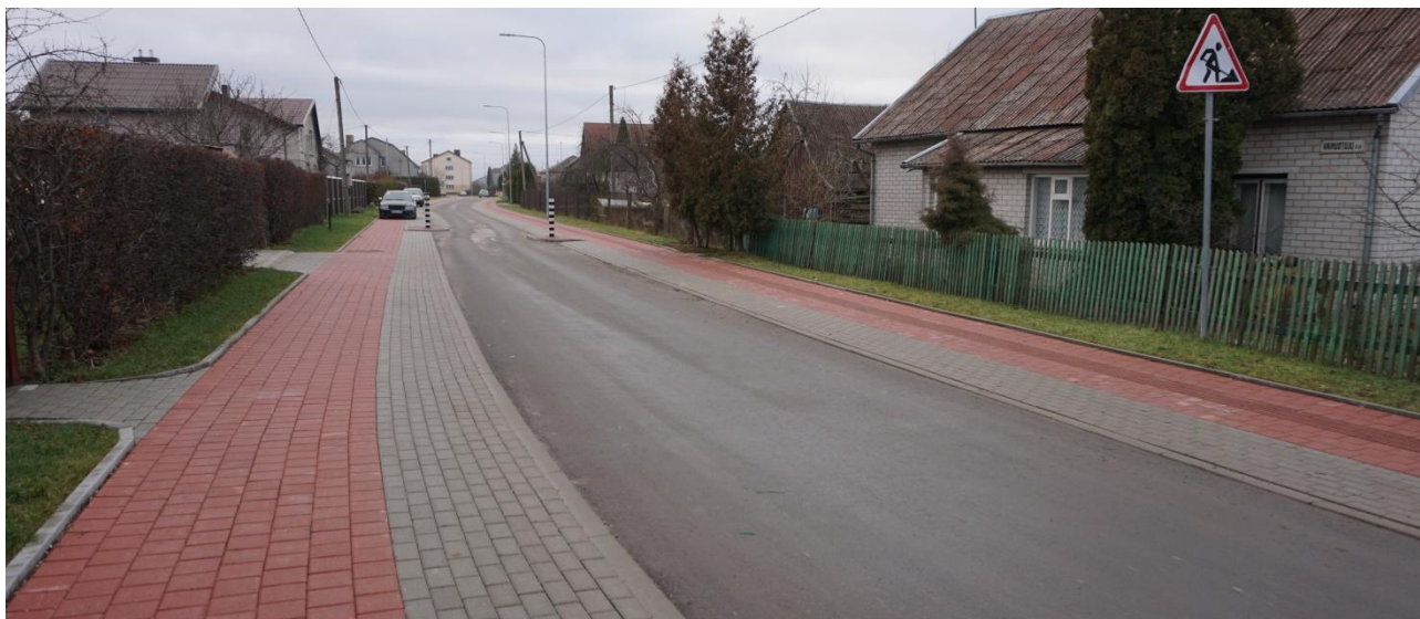
20 pav. Baigtas Vairuotojų gatvės Kretingoje kapitalinis remontas
