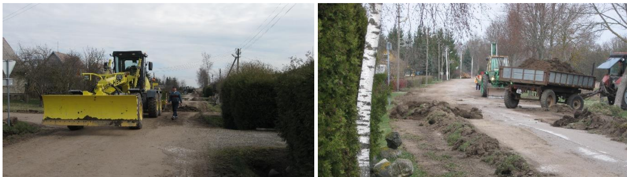
43 pav. Liepų g. paruošiamieji remonto darbai Laviuose (kairėje) ir Klevų g. paruošiamieji remonto darbai Erlėnuose (dešinėje)
