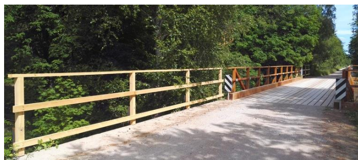
58 pav. Suremontuotas Kalgraužių tiltas
