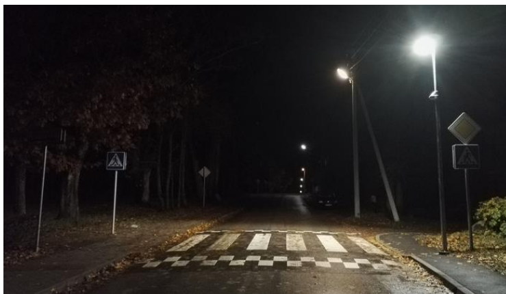
56 pav. Apšviesta pėsčiųjų perėja Laukžemės gatvėje
