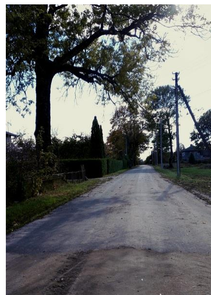
54 pav. Ištisinės asfalto dangos paklojimas Nausėdų kaime
