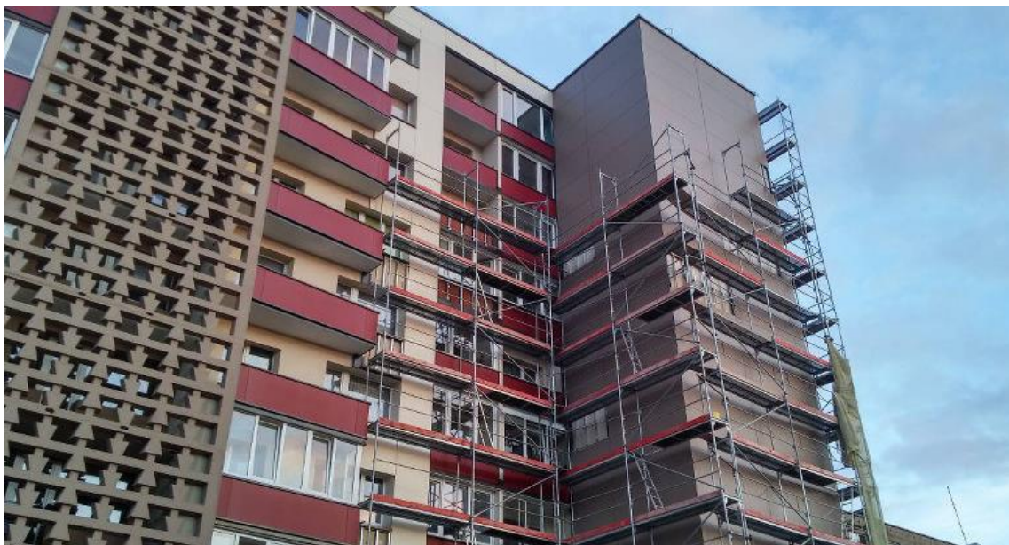
13 pav. Kretingos Topolių aklg. 5 daugiabučio renovacija
