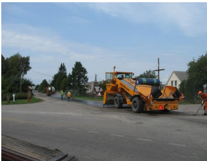
Mokyklos g. remonto darbai Juodupėnuose
