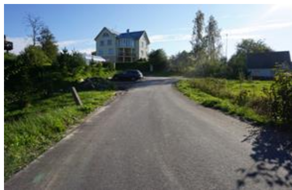
Pievų gatvėje paklota ištininė asfalto danga
